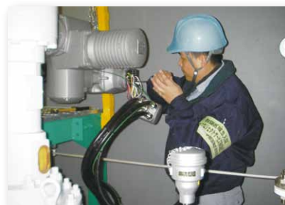
ケーブル接続確認
