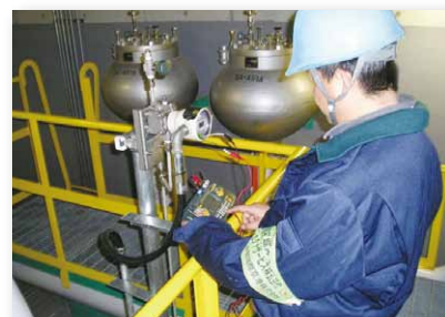
アクチュエーターへの圧力計AI信号確認
